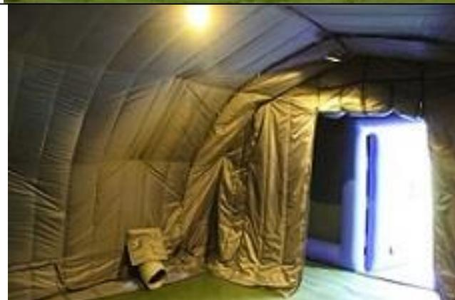
**3. Электрооборудование** – в зависимости от размеров, палатки включает в себя электросеть – лампы в влагостойких плафонах 4-8 шт. на модуль, влагостойкие прорезиненные розетки 4-6 шт., морозостойкий кабель около 12-30 м., электрощит (при сложном моделировании комплекса).
